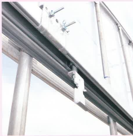
ドア枠を吊り下げます。
