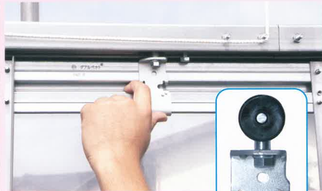
ドア枠を吊り下げます。
