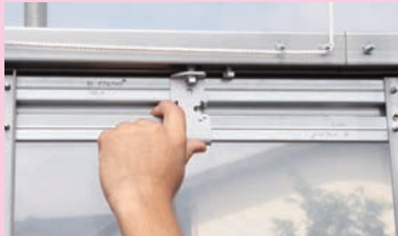
ドア枠を吊り下げます。
